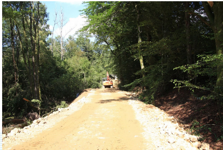
Création d'une route forestière
