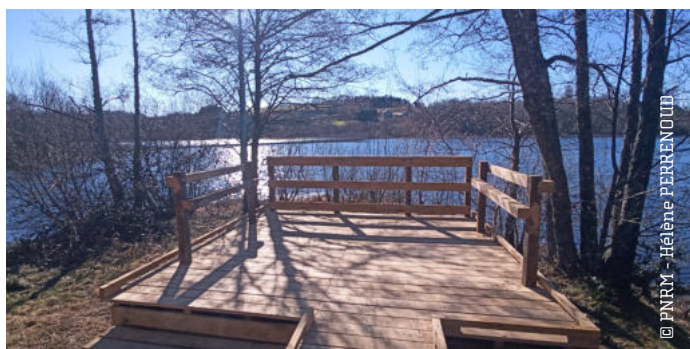
Le platelage du sentier d'interprétation de l'étang Taureau a été rénové, élargi par endroit. Des panneaux pédagogiques seront installés prochainement
