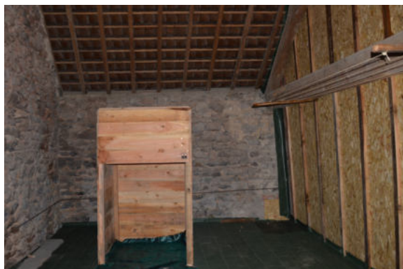
Aménagement d'une grange pour faciliter l'accueil d'une colonie de petits-rhinolophes.
